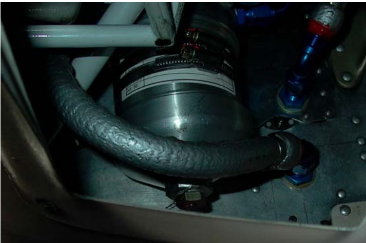
Fuel Filter durch die Cowling gesehen
